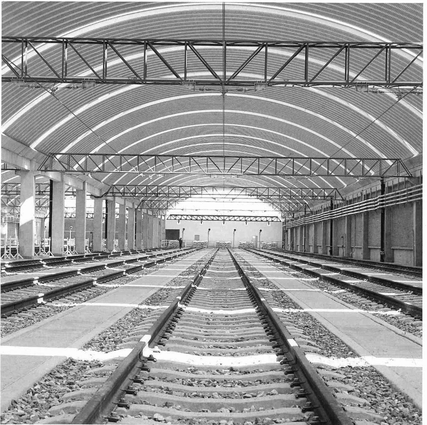
Nave de depósito en los talleres La Paz.
